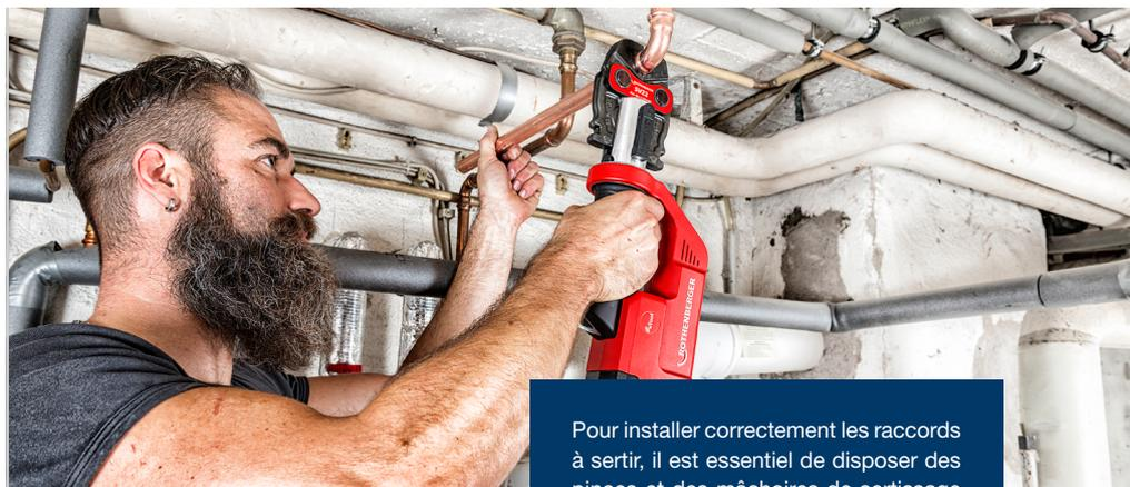
Pour installer correctement les raccords à sertir, il est essentiel de disposer des pinces et des mâchoires de sertissage adéquates. Vous assurez ainsi une connexion optimale entre le raccord et le tuyau et la garantie s'applique.
